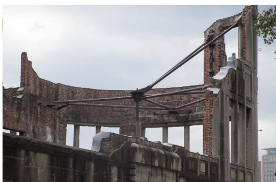
ポンドや支柱で補強した原爆ドーム
