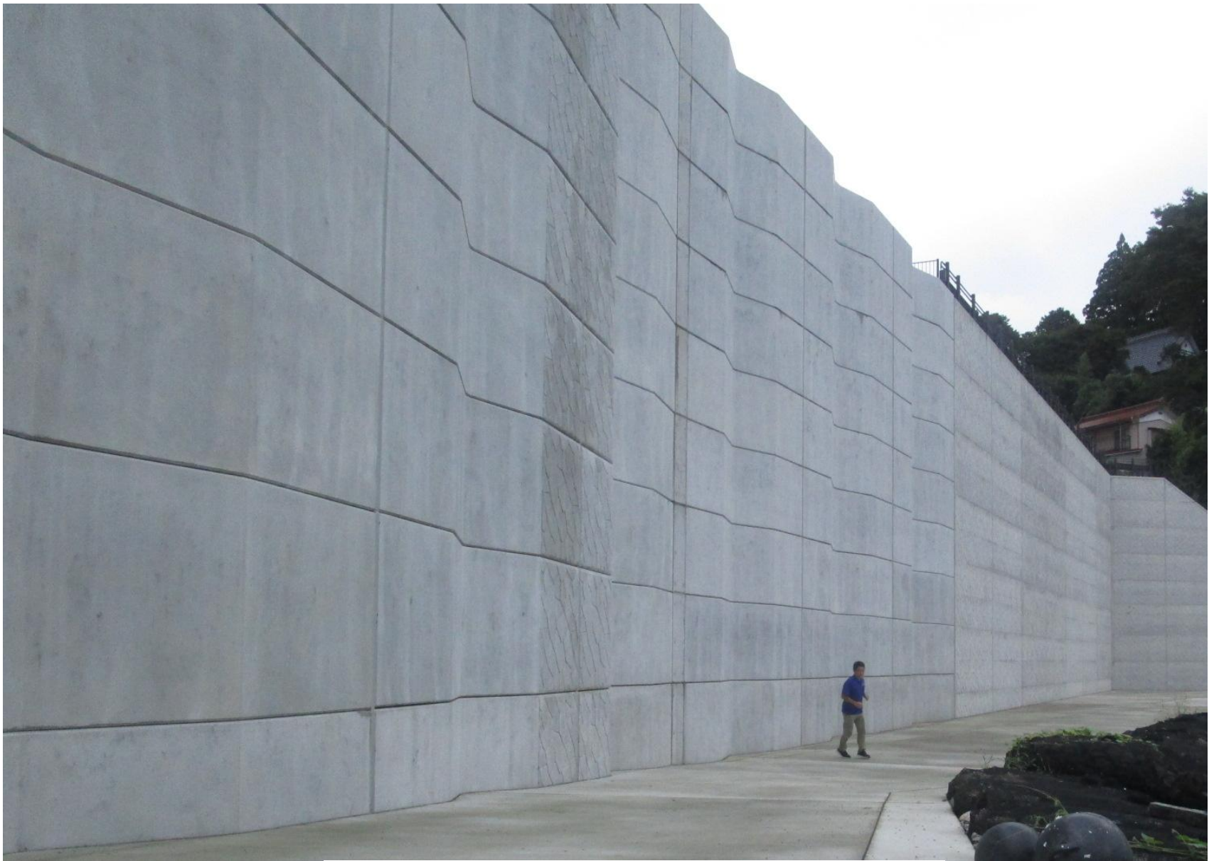
高さ14.7mの直立式防潮堤(二十一浜漁港)
