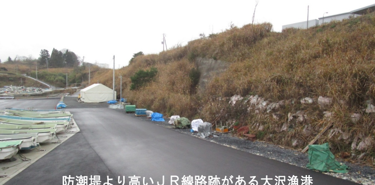
防潮堤より高いJR線路跡がある大沢漁港
