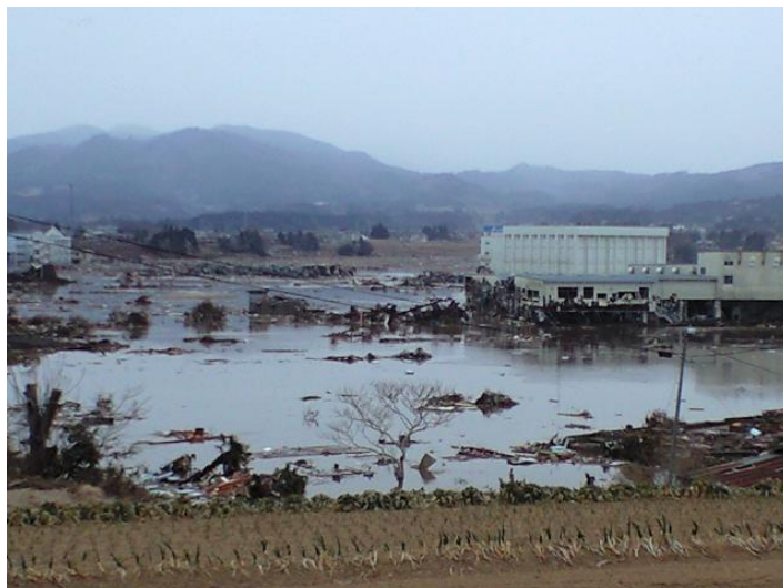
平成23年3月11日被災直後の波路上地区
