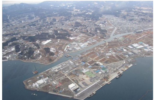
かさ上げ工事が進む南気仙沼地区
