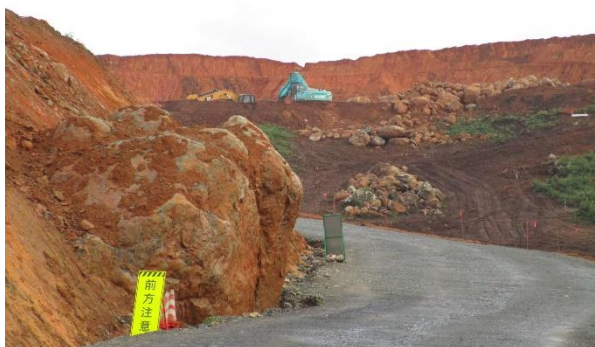
転石の大量発生などで完成が遅れる牧沢団地
